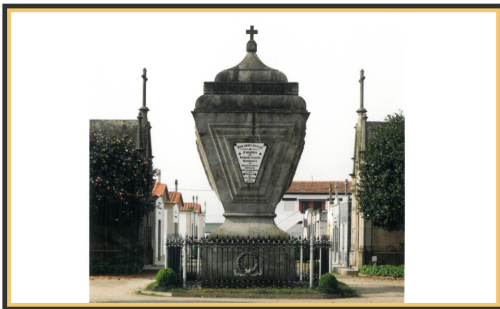
O Conselheiro José Guilherme Pacheco tinha indicado que gostaria de repousar num jazigo o mais levantado possível da terra. O Mausoléu, em forma de urna, localizado no centro de cemitério, foi projetado pelo Eng o João Rodrigues Pinto de Brandão, da freguesia de Mouriz.
