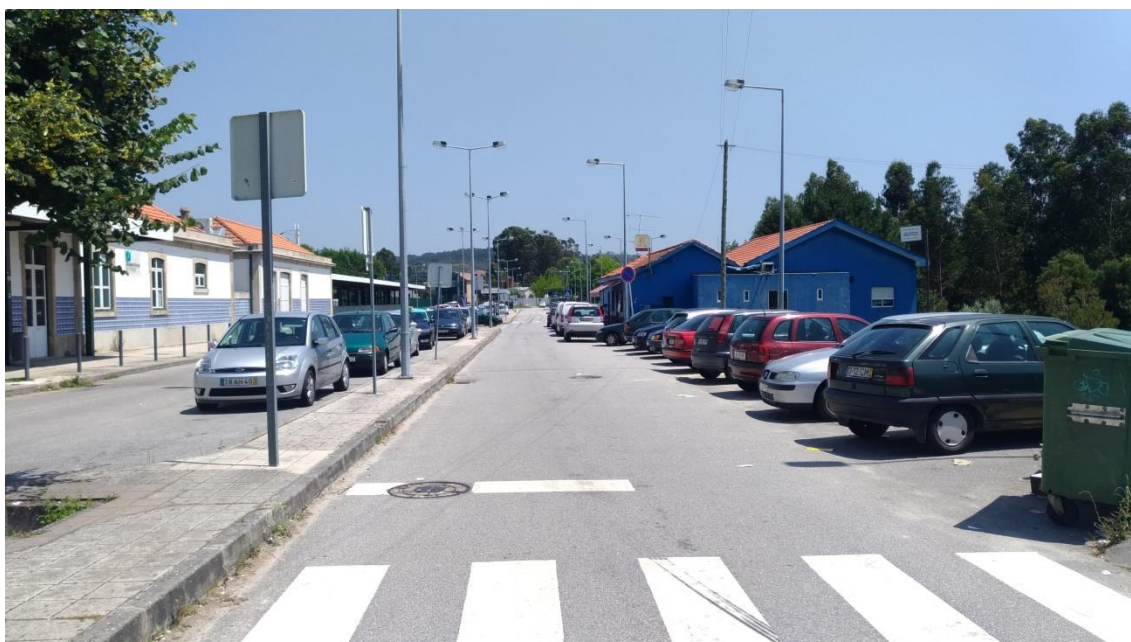
Fotografia 4 – Estação de Sobreira – Linha do Douro – e parque de estacionamento
