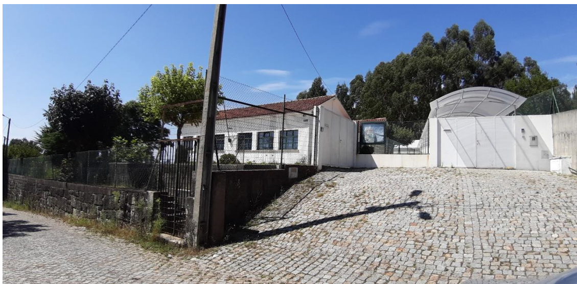
Fotografia 10 Equipamentos presentes na Área de Reabilitação Urbana de Astromil – Jardim de Infância de Astromil:
