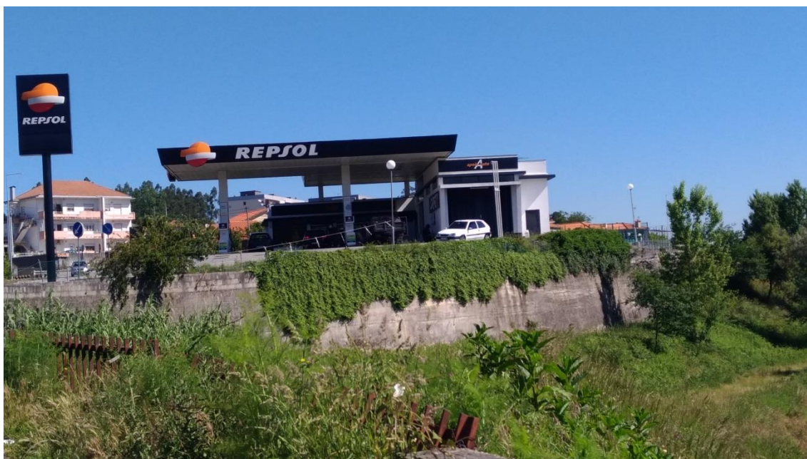
Fotografia 5 – Posto de combustível
