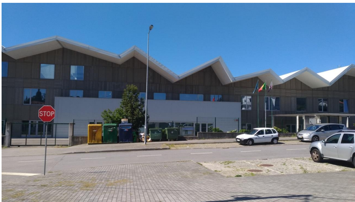
Fotografia 11 – Centro Escolar da Sobreira
