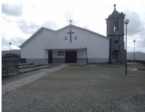
Fotografia 7 – Capela de São Sebastião
