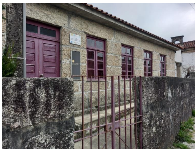
Fotografia 7 – Centro de Interpretação das Minas de Castromil
