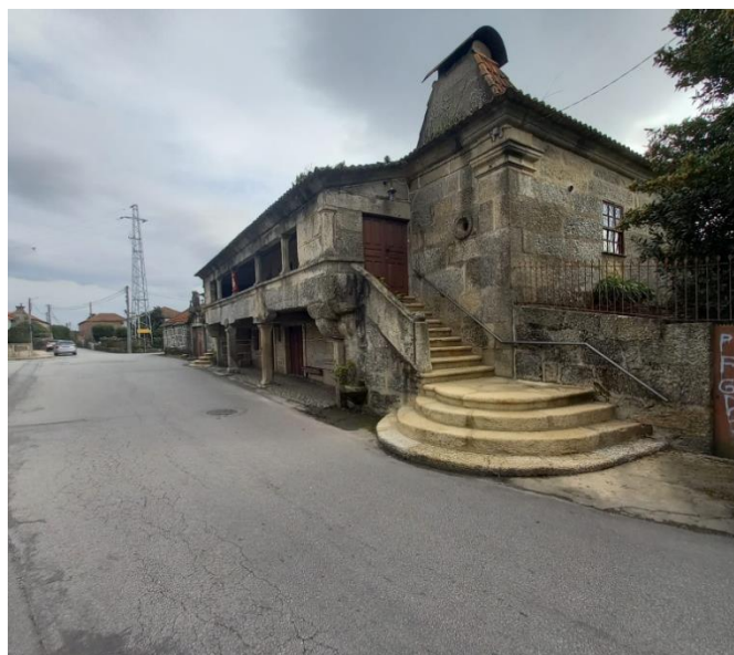
Fotografia 2- Exemplo de infraestruturas rodoviárias
