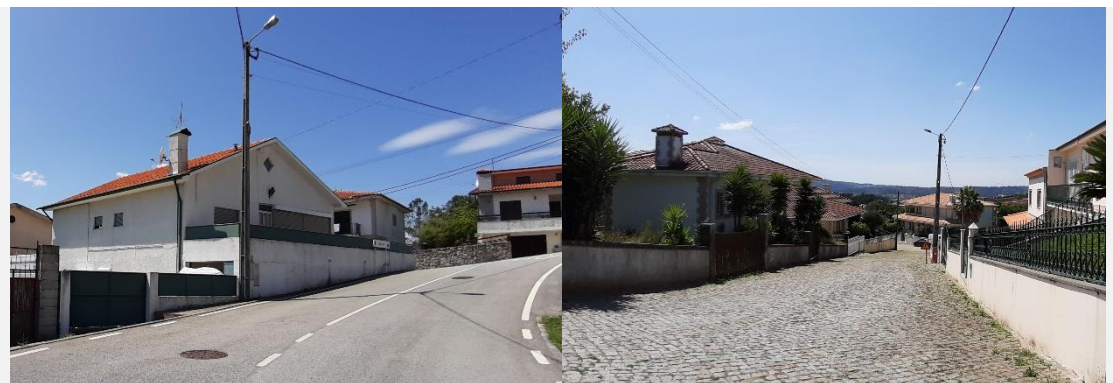
Fotografias 2 Exemplos das infraestruturas viárias existentes na Área de reabilitação na ARU de Astromil:
