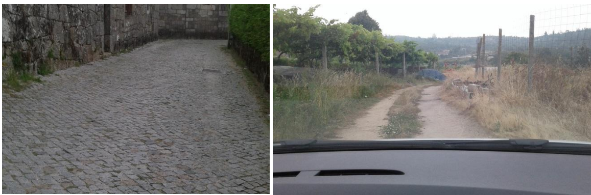
Fotografia 2- Exemplo de infraestruturas rodoviárias
