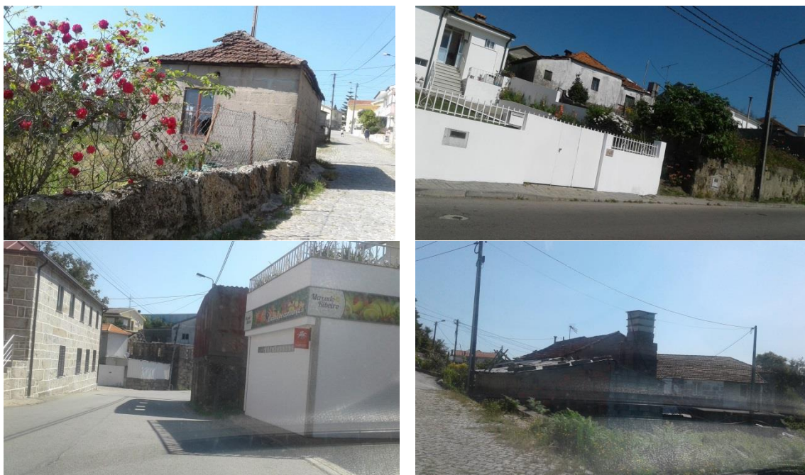
Fotografia 1- Exemplos do edificado na ARUV
