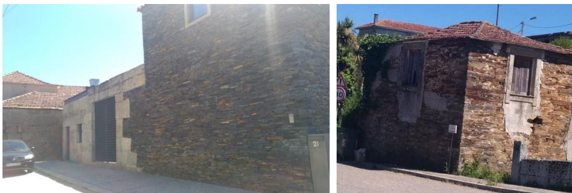
Fotografia 8- Construções em Xisto
