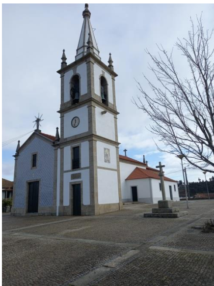
Fotografia 6 – Igreja Velha de São Pedro (Matriz da Sobreira)
