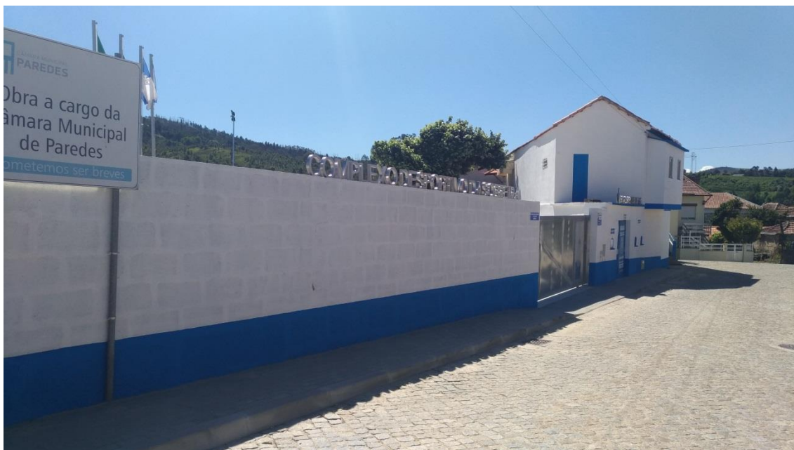
Fotografia 13 – Complexo Desportivo da Sobreira
