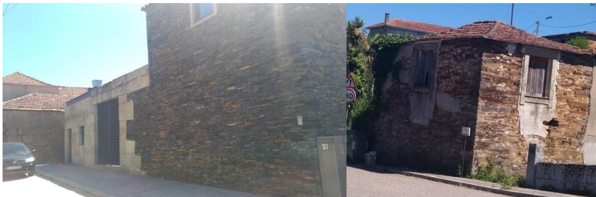
Fotografia 8- Construções em Xisto
