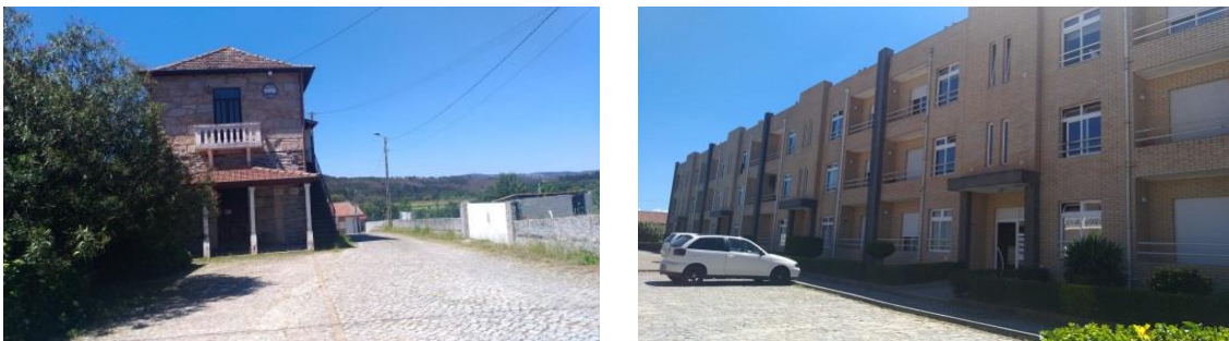
Fotografia 2 – Edifício da ARUS
