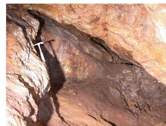
Desmonte mineiro subterrâneo onde a sustentação do tecto é apoiada por um muro de pedra antigo.
