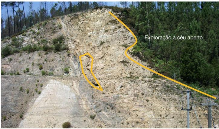
O corte da linha de caminho de ferro permite observar a exploração sub-vertical paralela à falha, colmatada com entulho por motivos de segurança da CP.
