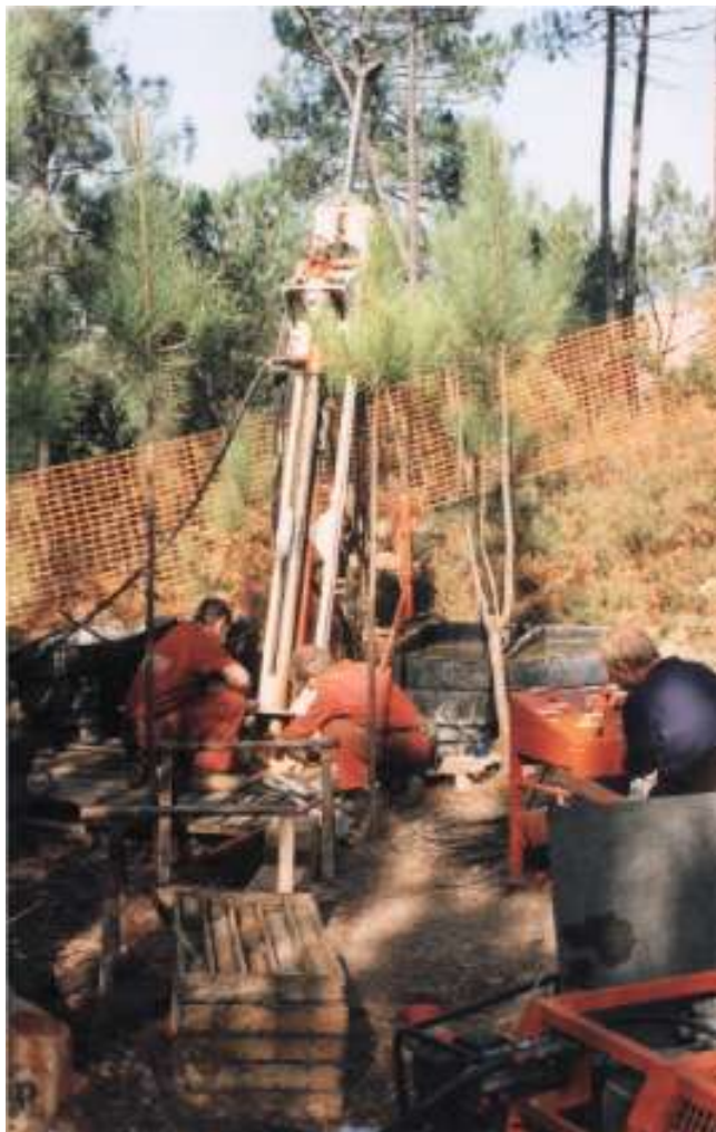
Realização de sondagem
