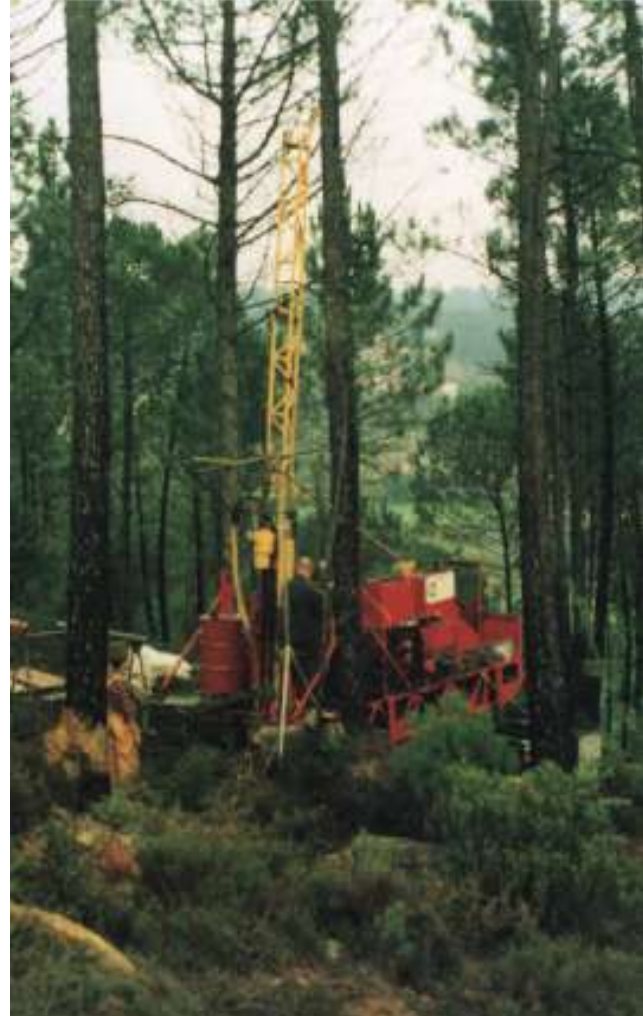
Realização de sondagem
