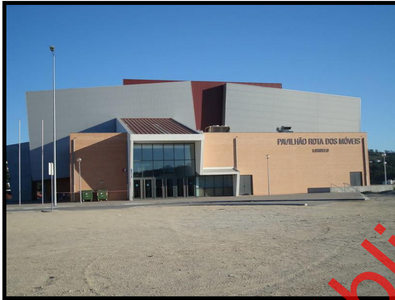
Fotografia 21 – Pavilhão Rota dos Móveis
