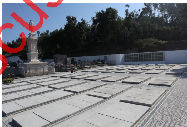
Fotografia 1 – Ampliação do cemitério de Vandoma, inaugurada a 20 de julho de 2019.
