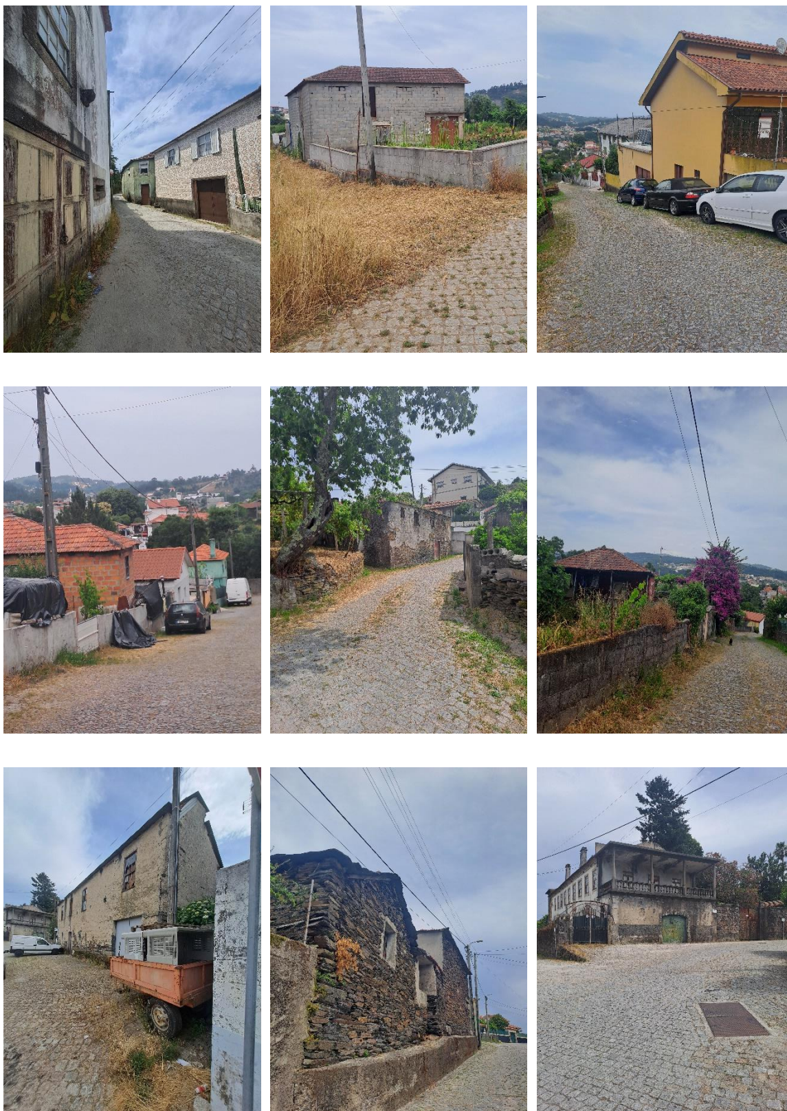
Figura 5 - Exemplos do edificado presente na Área de Reabilitação Urbana de Casconha:
