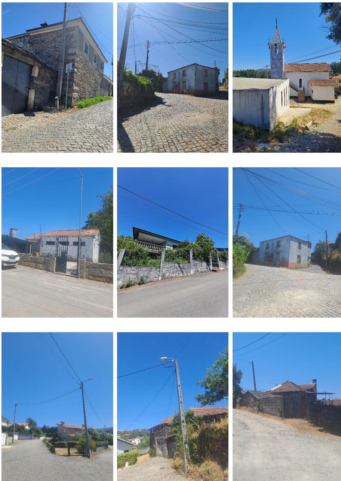
Figura 5 - Exemplos do edificado presente na Área de Reabilitação Urbana de Alvre:
