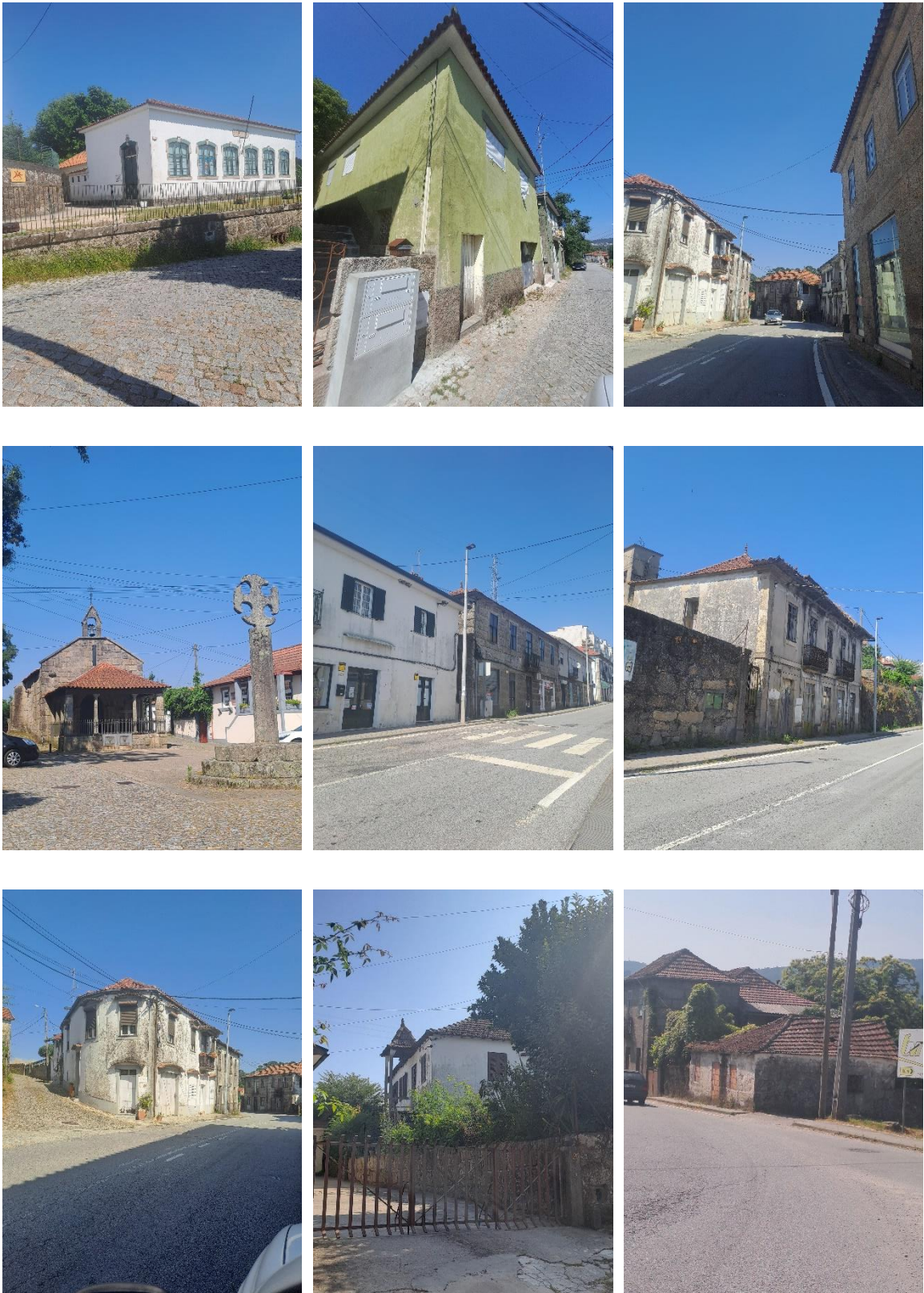
Figura 5 - Exemplos do edificado presente na Área de Reabilitação Urbana de Cete:
