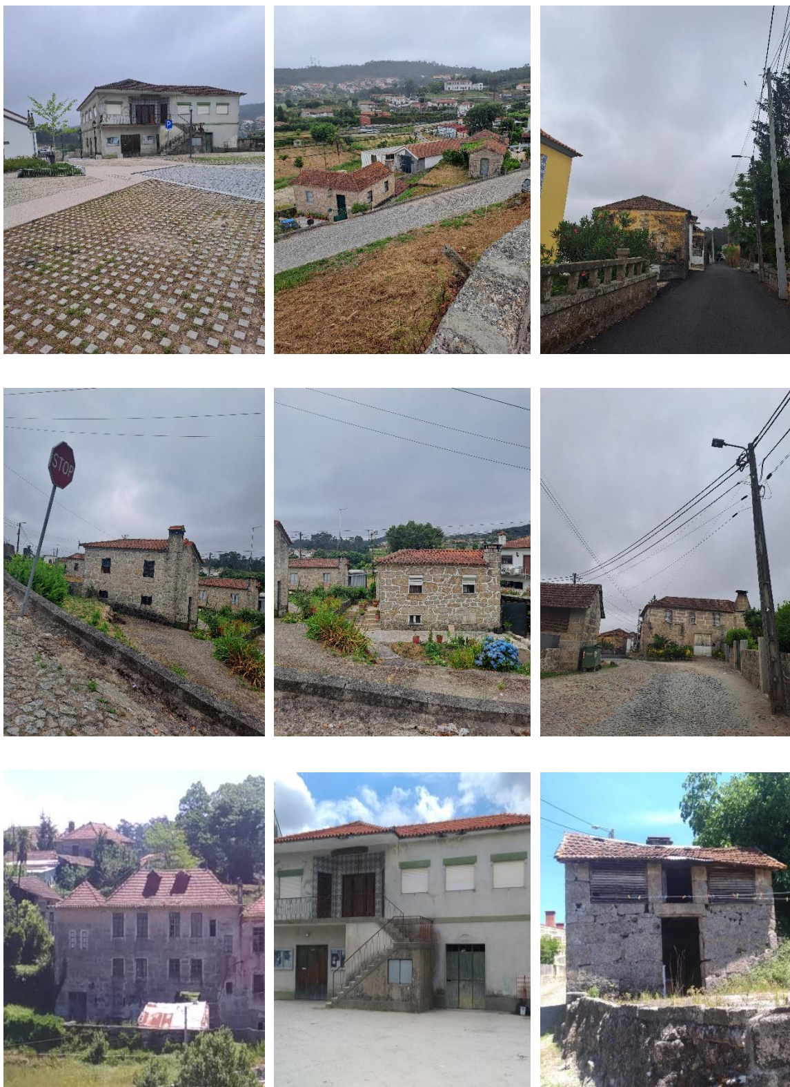
Figura 5 - Exemplos do edificado presente na Área de Reabilitação Urbana de Parada de Todeia:
