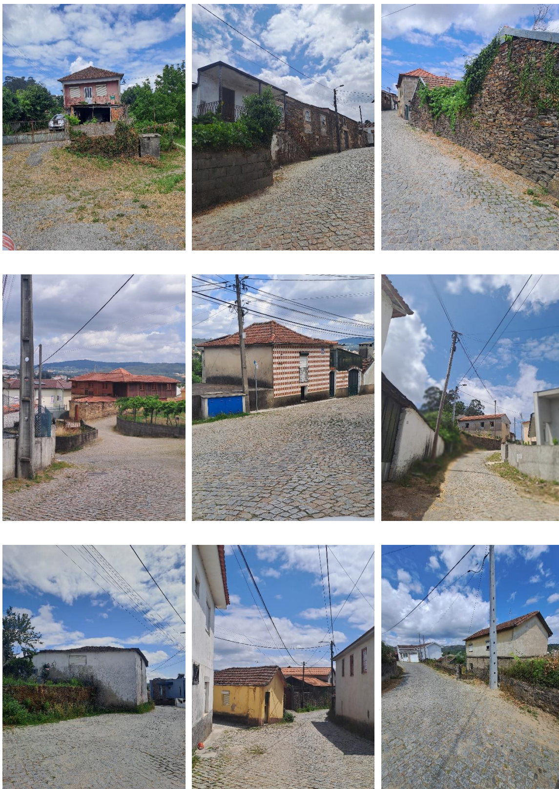
Figura 5 - Exemplos do edificado presente na Área de Reabilitação Urbana de Recarei e parcial da Sobreira:
