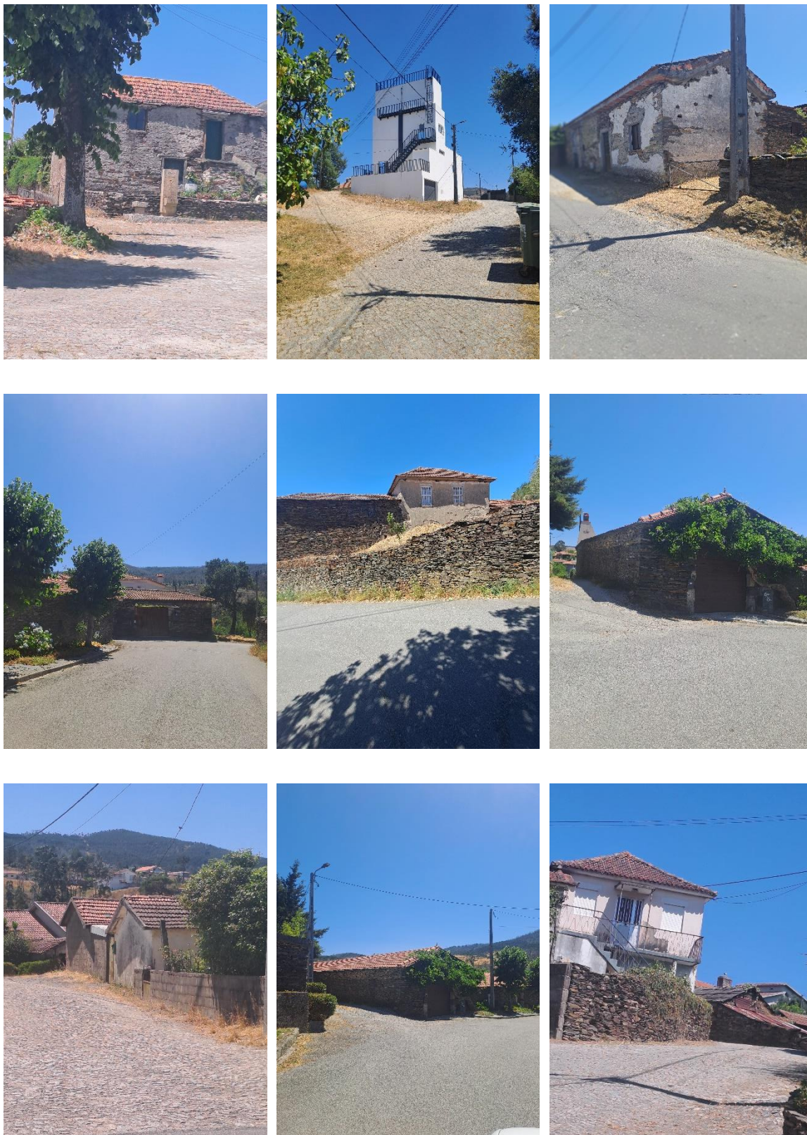
Figura 5 - Exemplos do edificado presente na Área de Reabilitação Urbana de Santa Comba:
