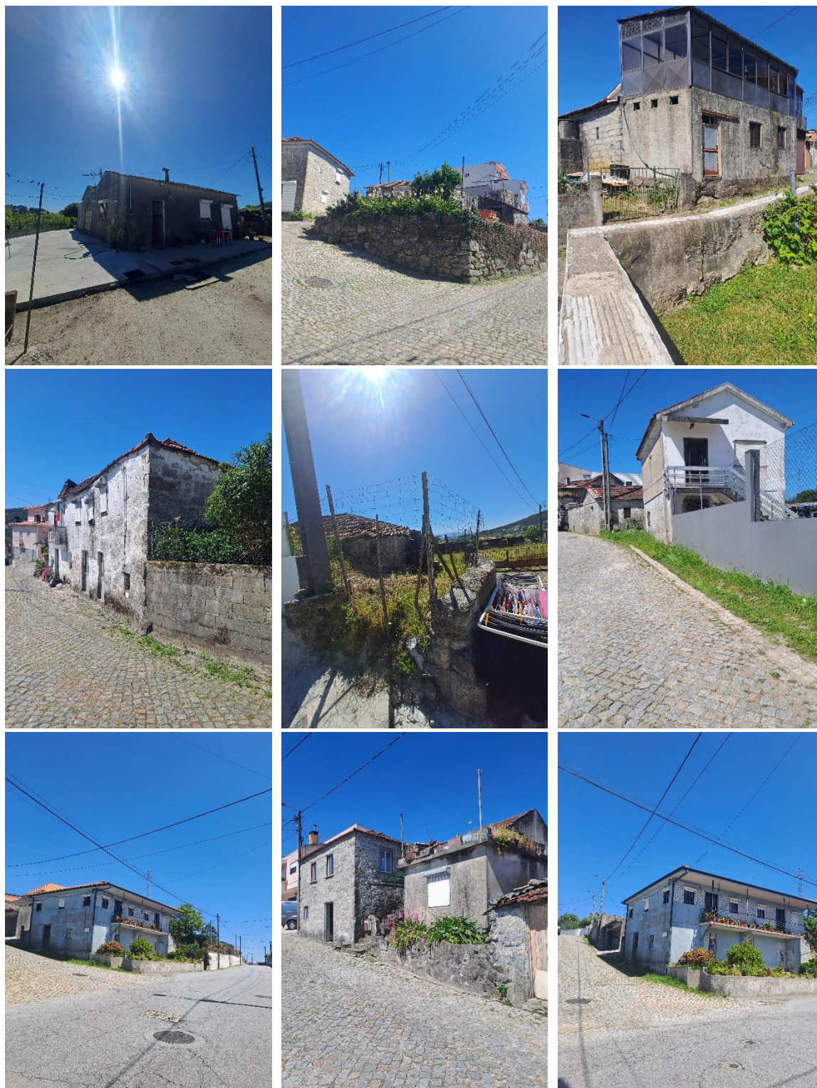
Figura 6 - Exemplos do edificado presente na Área de Reabilitação Urbana de Vandoma:
