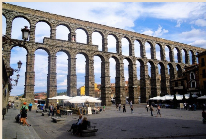
Aqueduto romano de Segóvia, uma das mais notáveis construções hidráulicas existentes em Espanha. Em termos de salvaguarda patrimonial é um dos aquedutos mais bem preservados, construídos durante o Império Romano. Na sua construção foram utilizados cerca de 20.400 blocos de granito, sobrepostos sem qualquer tipo de argamassa ou cimento.
