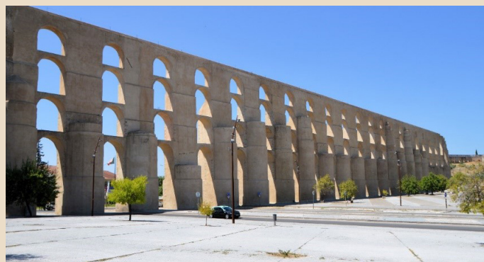
Aqueduto da Amoreira, na sua chegada à cidade de Elvas. A sua construção, iniciada em 1529, foi dirigida pelo arquiteto Francisco de Arruda. A extensão total do aqueduto é de 7 790 m e a sua altura máxima é de 31 m, verificada na arcada sobreposta em quatro ordens de arcos e que atravessa o vale de S. Francisco, com 1 113 m de comprimento. Monumento Nacional, desde 1910. Em 2012 passou a integrar a lista de bens culturais da UNESCO, como Património Mundial.
