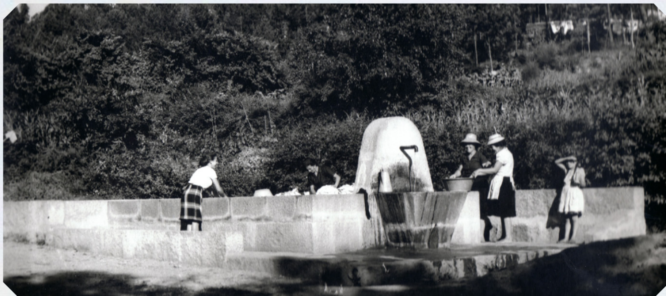
Foto do Arquivo Municipal de Paredes - Fontanário Lavadouro de Parteira de Baixo - Lordelo, Paredes
